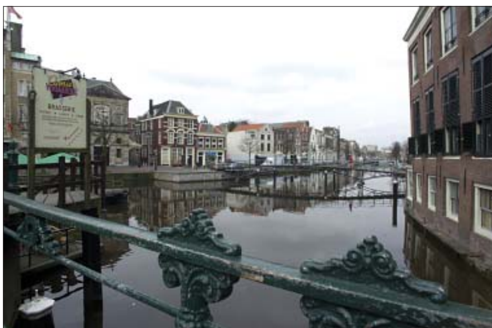
In december gaat de eerste spade de grond in voor het Aalmarktproject
