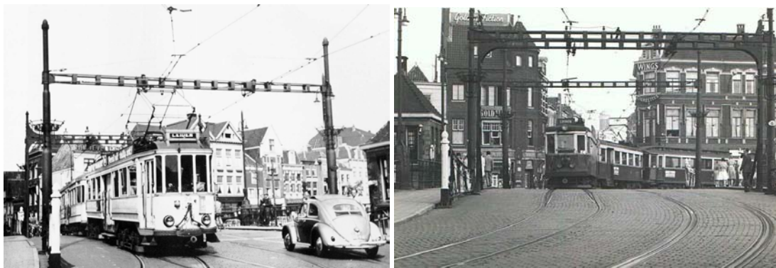
Figuur 23 De Blauwpoortsbrug medio 1960 - van beide richtingen gezien, brugconstructie met portalen
