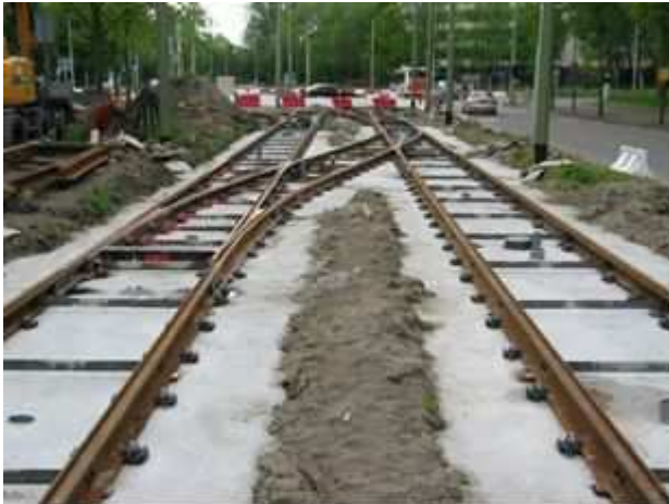
Figuur 8 Spoor op betonplaat, Den Haag – foto www.digitaletram.nl
