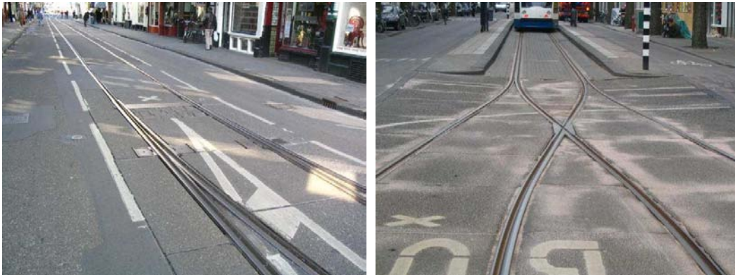
Figuur 7 Links enkelspoor met veerwissel, rechts strengelspoor, beide Amsterdam – foto's TransTec
