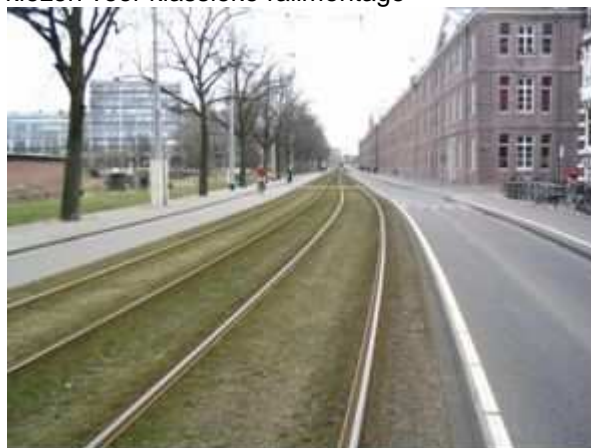
Figuur 5 Trambaan uitgevoerd met(zeer kort gemaaid) gras rond groefrail
