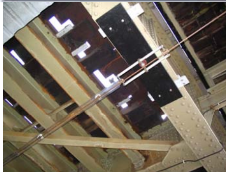
Figuur 19 Oostelijke onderdoorgang IJtram / Amsterdam CS, hoogte 4,2 meter –foto TransTec
