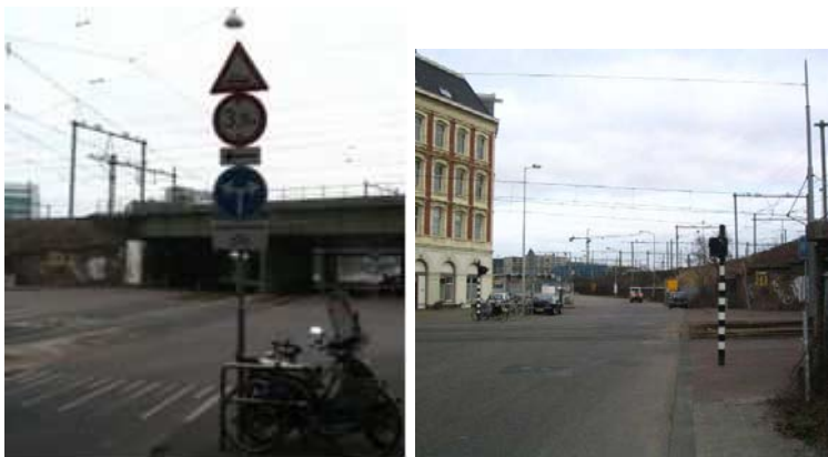
Figuur 14 Op 3,9 meter opgehangen bovenleiding in de Czaar Peterstraat Amsterdam – foto TransTec
