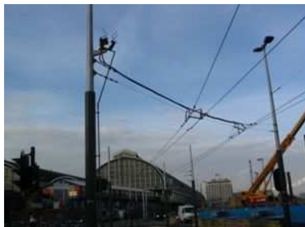
figuur 16 Scheider in naspanninginrichting IJtram Amsterdam achter CS, links en rechts zijn gekoppeld
