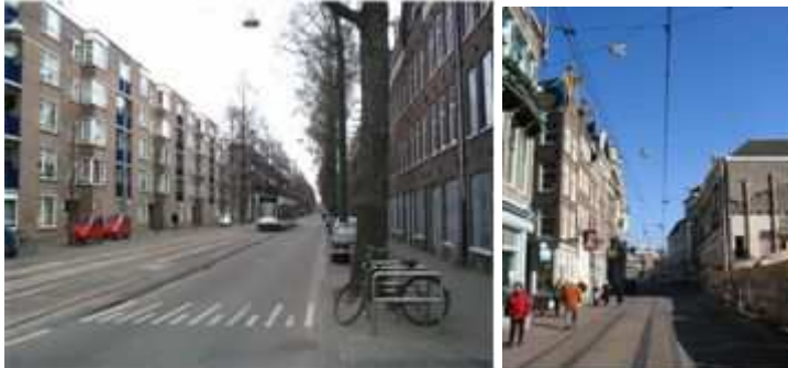
Figuur 13 Links aan de gevels en soms ook aan palen opgehangen draagkabelbovenleiding, rechts een aan de gevel opgehangen klassieke bovenleiding (enkelspoor met versterkingsleiding) – foto's TransTec
