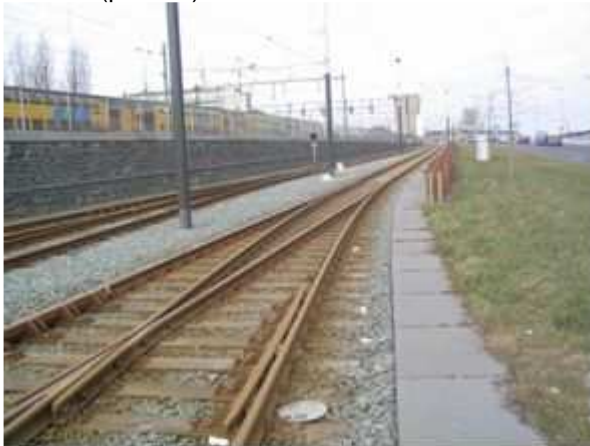
Figuur 9 Wissel op houten dwarsliggers, IJtram Amsterdam – foto TransTec
