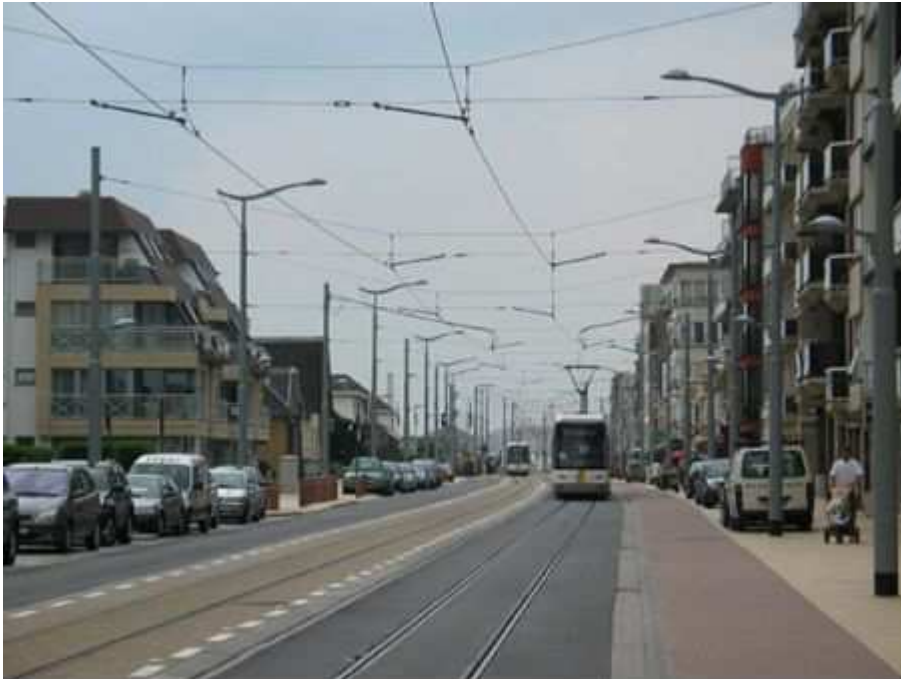
Figuur 15 Duidelijk herkenbare zig-zag van de rijdraad – Kusttram België - foto: digitaletram.nl. Let ook op de bovenleidingpalen, annex straatverlichtingsarmaturen.
