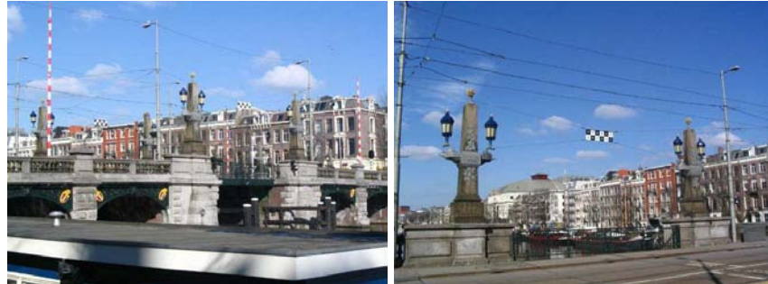
Figuur 22 Hogesluis Amsterdam, boven basculekleppen doorlopende bovenleiding - foto's TransTec
