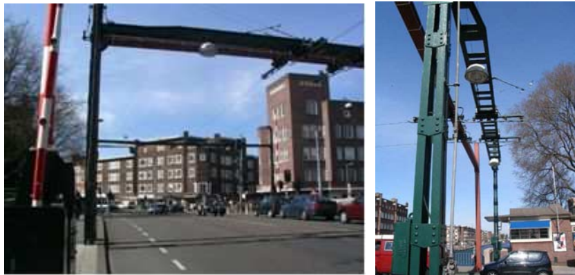
Figuur 24 De Kinkerbrug in Amsterdam, vergelijkbare bovenleidingconstructie met de Blauwpoortsbrug destijds – foto TransTec
