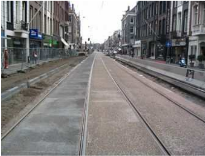
Figuur 4 Amsterdamse trambaan met betonplaatverharding – foto TransTec
