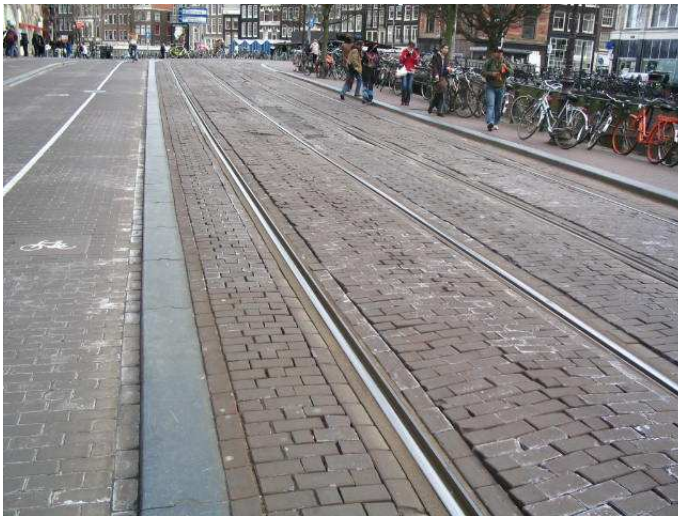
Figuur 2 Klinkerverharding in Amsterdamse vrije trambaan – foto TransTec
